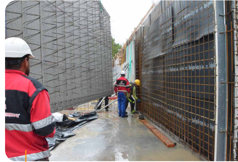
Het geprefabriceerd betonelement wordt voor de beschoeiingstechniek geplaatst.
