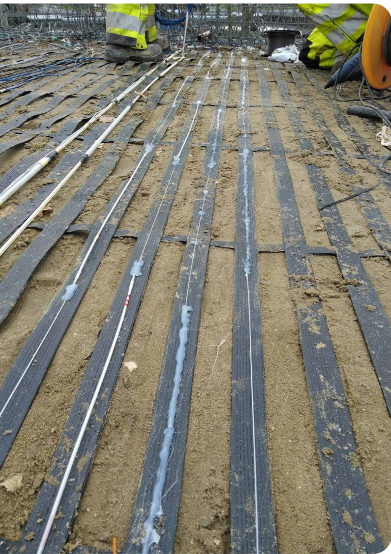
Er werd geëxperimenteerd met verschillende types optische vezelsensoren die op het geogrid werden bevestigd.
