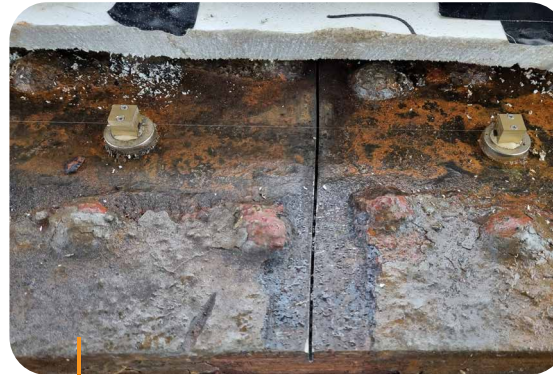
Dankzij de optische reksensoren konden de dynamische rekken in het brugdek gedetailleerd worden opgevolgd.
