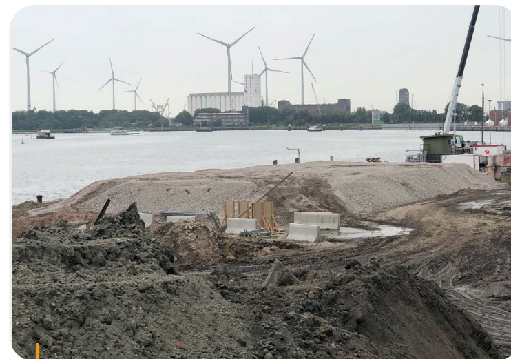
Belastingsproef ter verificatie van de stabiliteit van de kaaimuur met behulp van betonpuin.
